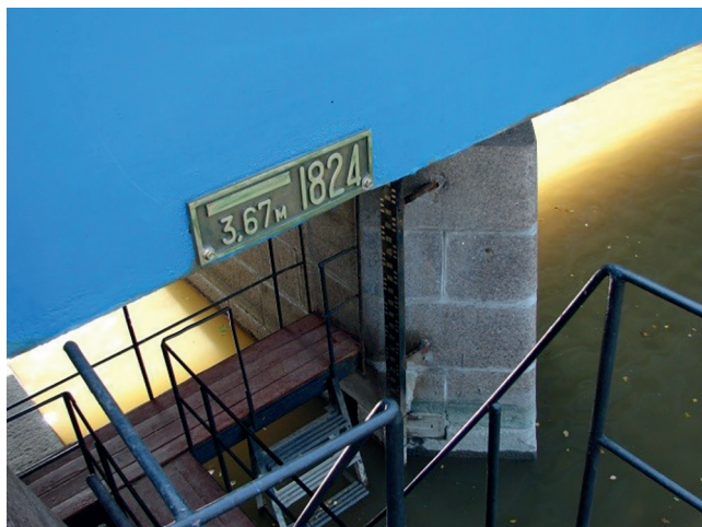
Рис. 1. Кронштадтский футшток, расположенный на быке Синего моста через Обводной канал: оцифрованная рейка и табличка с отметкой высоты катастрофического наводнения 7 (19) ноября 1824 г.
